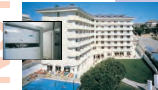
Hotel Savoy *** (Lloret de Mar) Climatització
